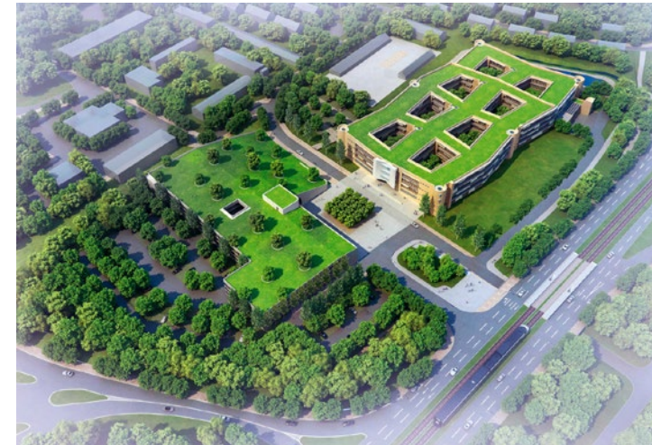
PROJEKT DM ZENTRALE IN KARLSRUHE 17.000m 2 Betonkernaktivierung AG Max Bögl, Stuttgart
