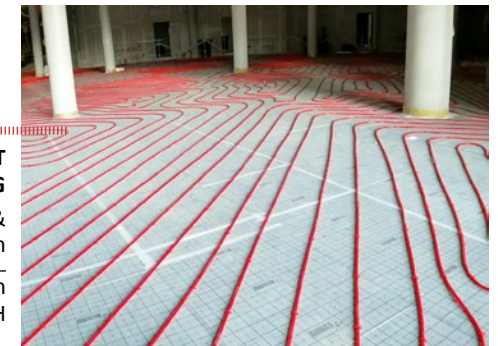
PROJEKT CCH HAMBURG 800m 2 Betonkernaktivierung & 6500m 2 FBH Tackersystem AG Caverion Deutschland GmbH
