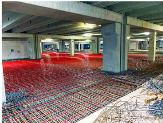
PROJEKT ARBURG BA23 IN LOSSBURG 10.000m 2 Betonkernaktivierung AG Volz GmbH Heizung · Klima · Sanitär
