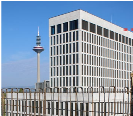
PROJEKT CW KULTUR U. SPRACHEN, FFM Betoneinlegearbeiten: Betonkernaktivierung, Regenwasser, Lüftung, Nutzfläche 20.000m 2 AG LEONHARD WEISS GmbH & Co. KG, Langen
