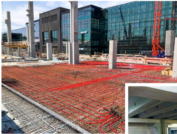
PROJEKT ARBURG BA23 IN LOSSBURG 10.000m 2 Betonkernaktivierung AG Volz GmbH Heizung · Klima · Sanitär
