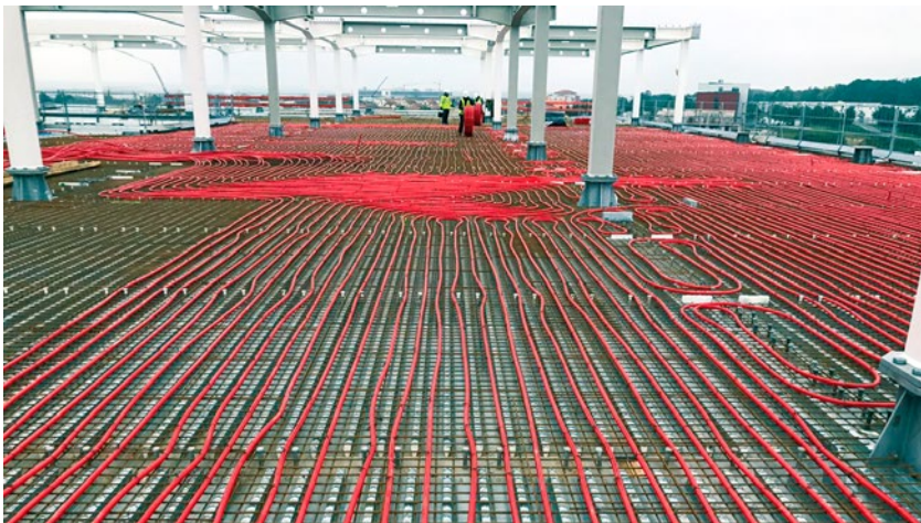
PROJEKT WORLD OF SPORTS IN HERZOGENAURACH 33.500m 2 Betonkernaktivierung GU Ed. Züblin AG, Stuttgart
